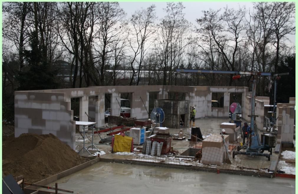
Im neuen Jahr wird dann zunächst die Decke über dem Erdgeschoss eingeschalt und mit Maurerarbeiten fortgeführt. Für März/April ist dann bereits der Dachstuhl
